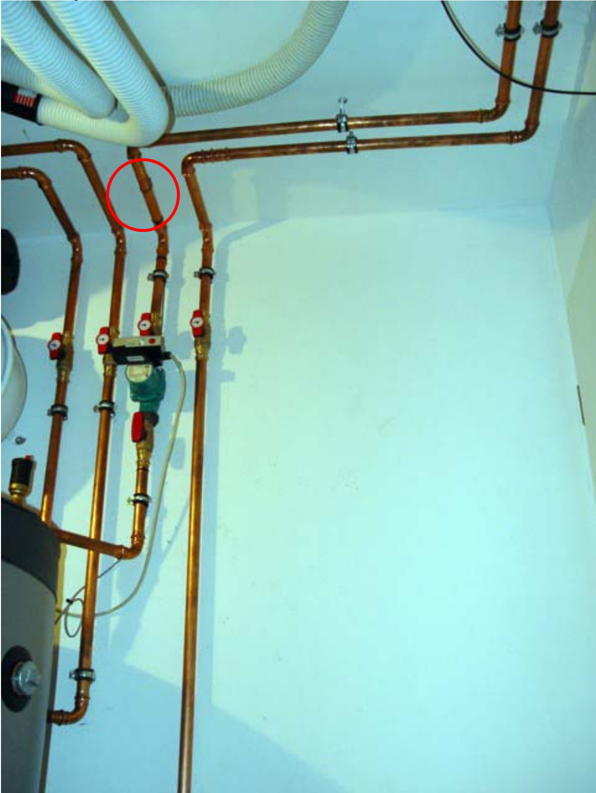
Sekundärseite mit Fühler am VL Roter Kreis und U-Pumpe
