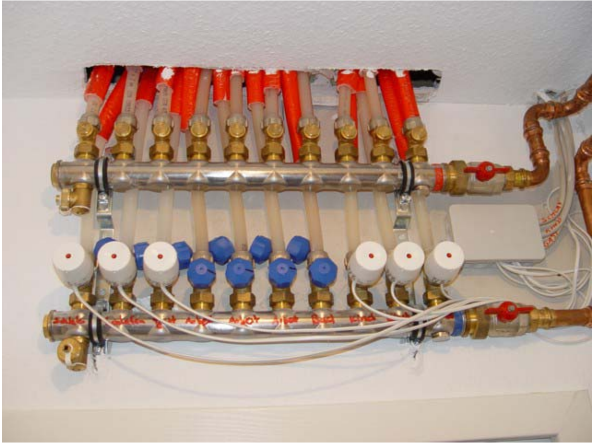
Heizkreisverteiler OG
